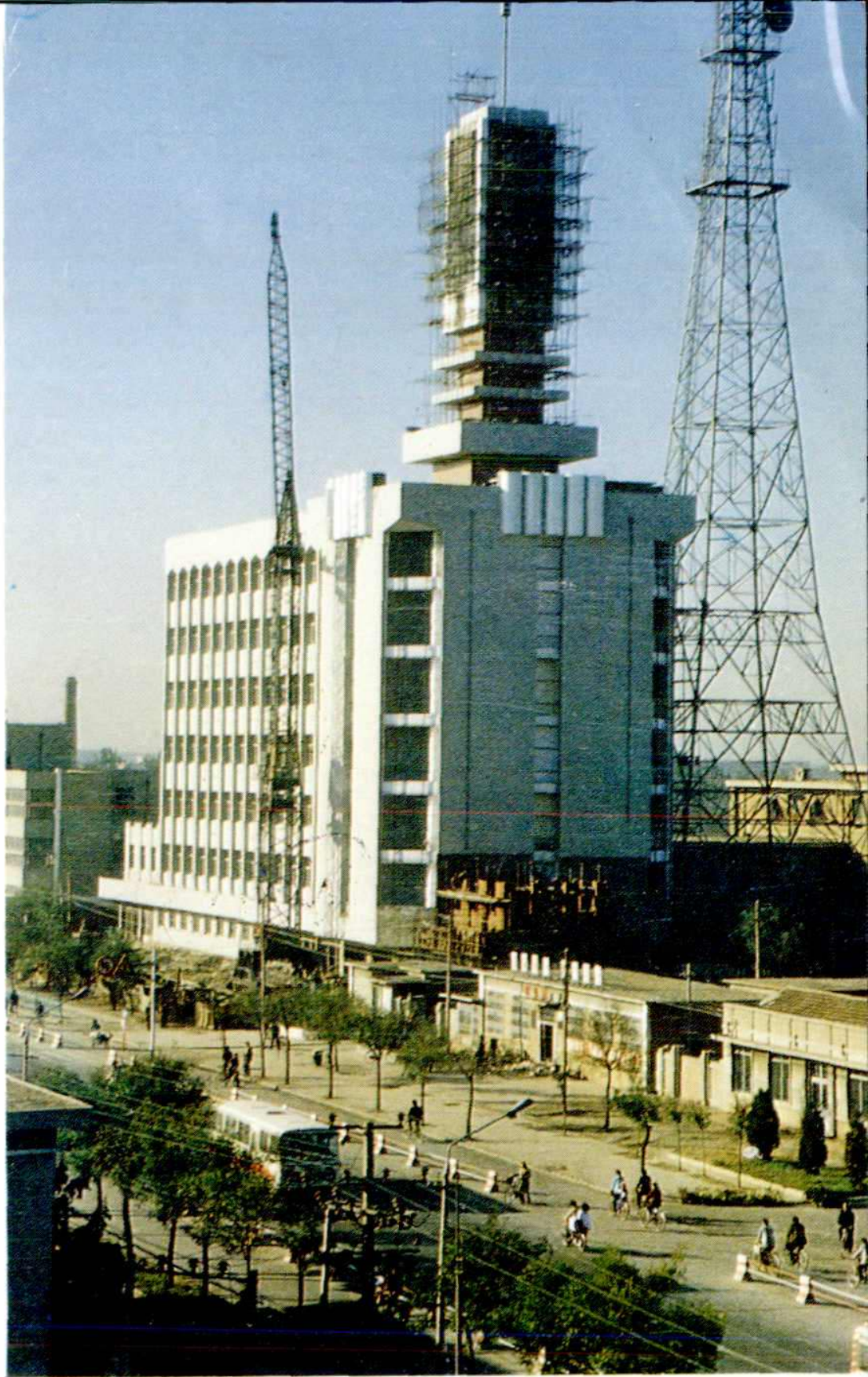
正在建设中的沧州电信大楼（1990年10月摄）
