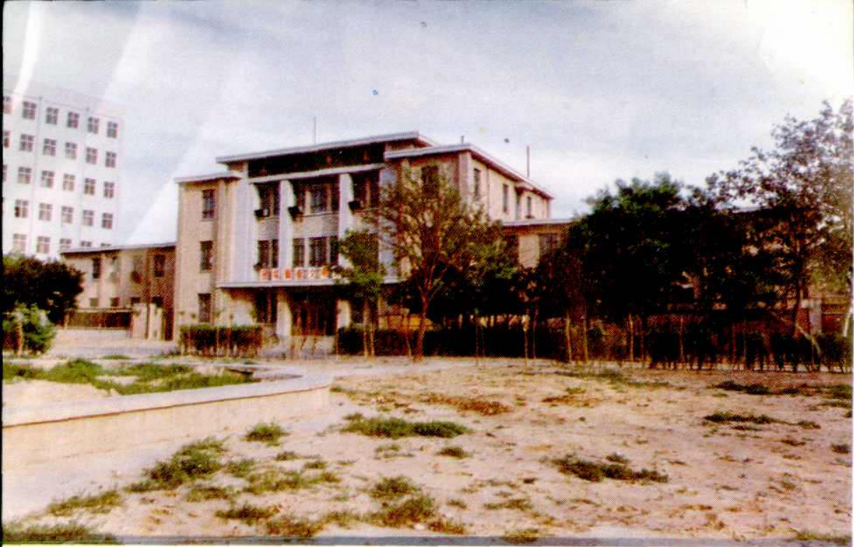
西环中街院内综合通信楼（1974年竣工）
