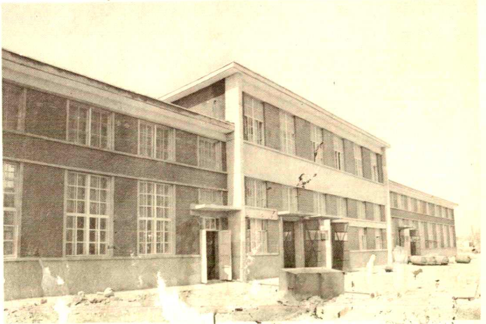
T602 添加剂车间竣工
