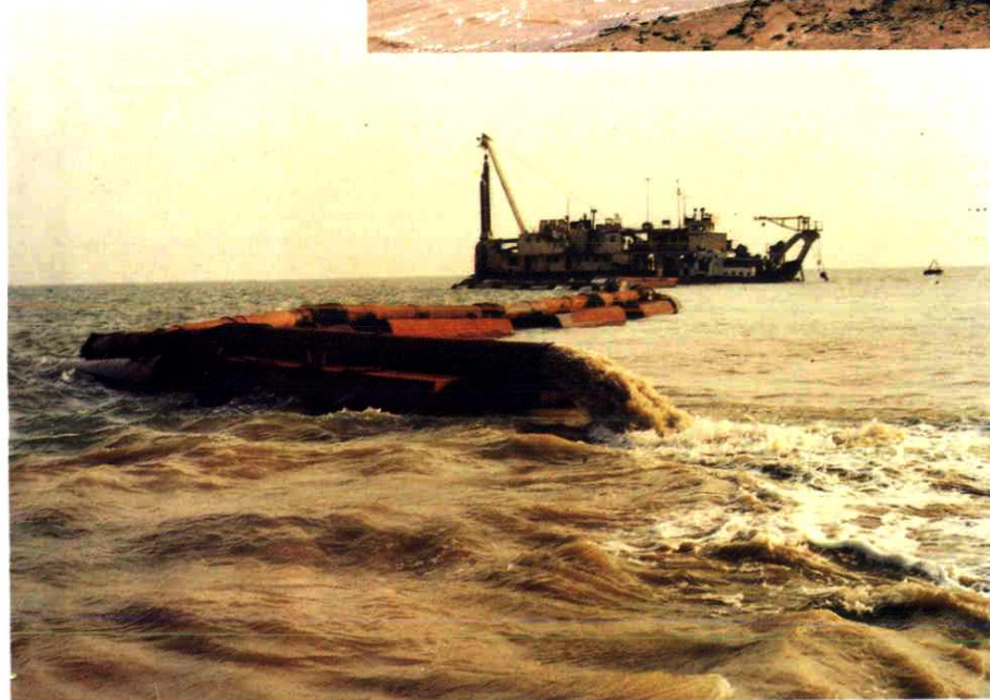
吸泥船在黄河口施工
