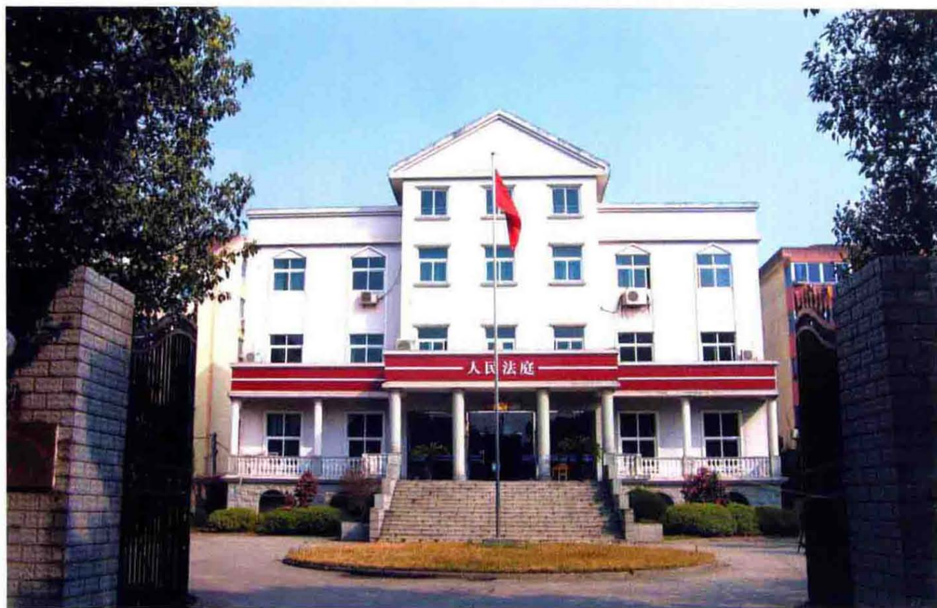
德清县人民法院新市人民法庭
