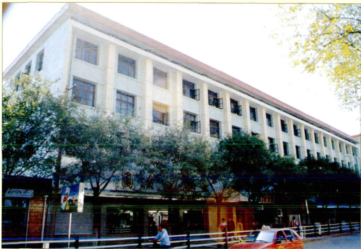
▲ 延安地区财政局办公楼
