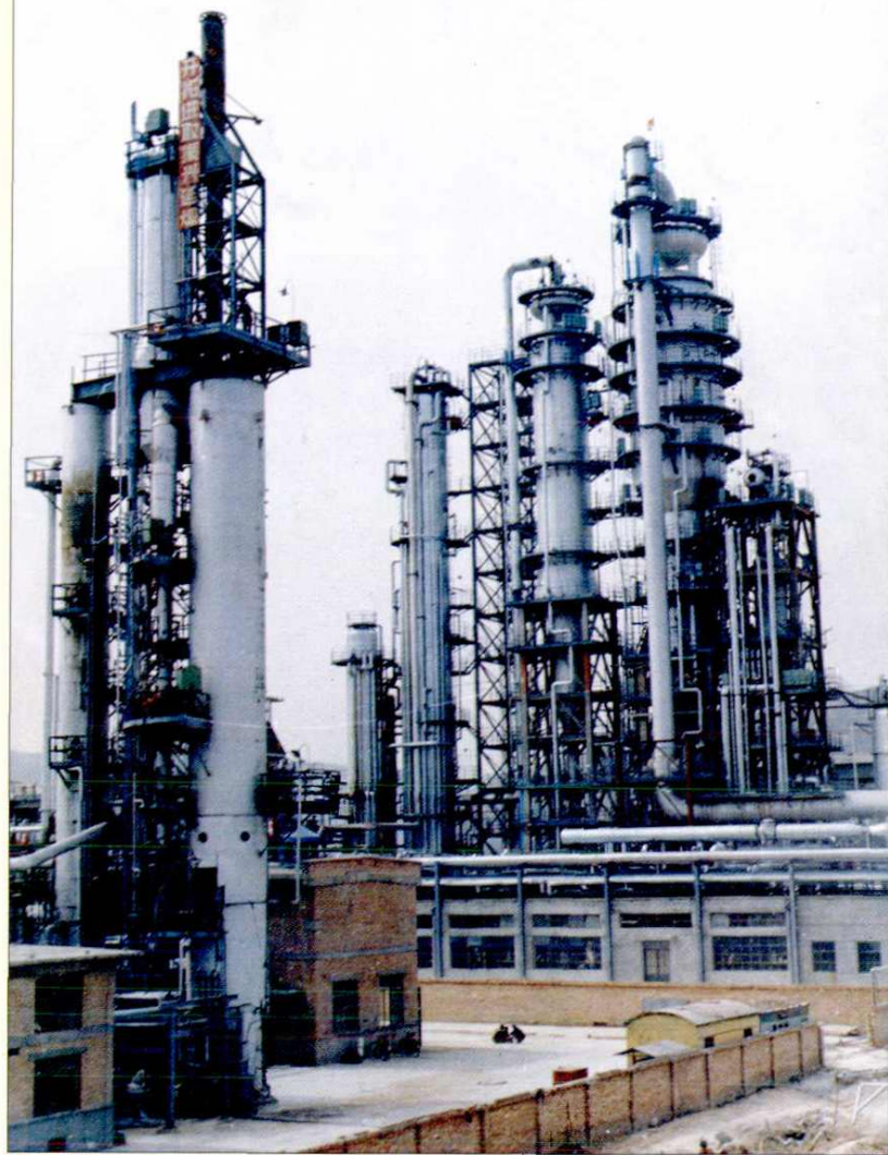
延安炼油厂炼油塔
