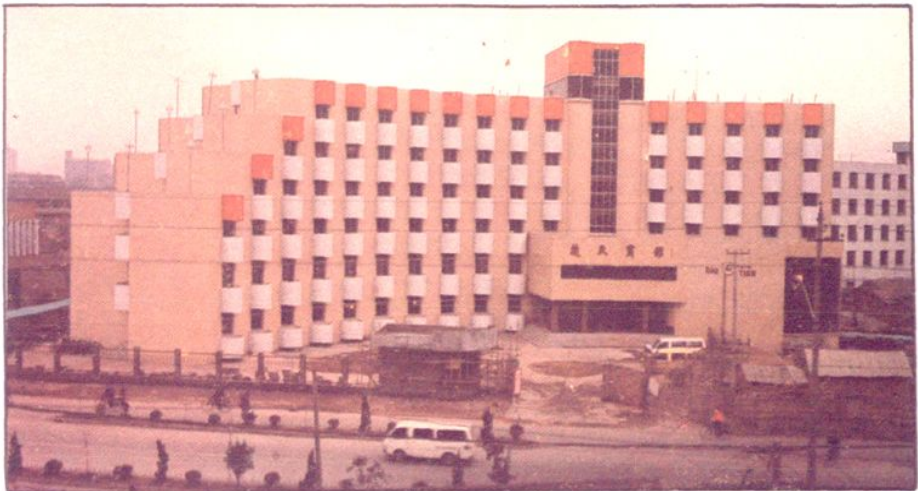
▲ 淮阴楚天宾馆，建筑面积7982平方米，框架六层，平面呈圆弧型。质量评定优良。
