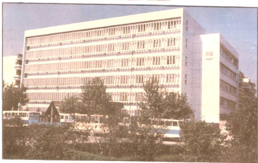
▶ 交通部二 航局三公司住 镇江办公楼， 六层框架，建 筑面积4729平 方米。质量评 定优良。
