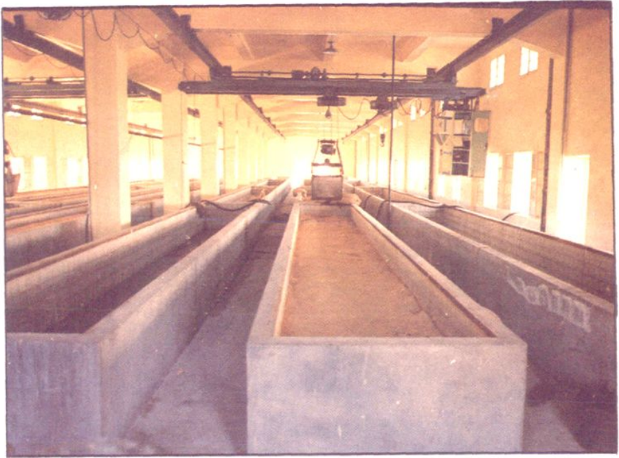
▶ 镇江恒顺酱醋厂，框架三层，三六八三平方米，大面积耐酸陶板一次镶贴成功。图为醋池。
