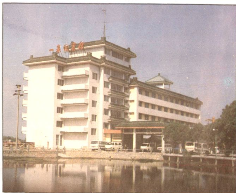
◀ 镇江一泉宾馆客房 楼框架结构，建筑面 积6662平方米。质量 评定优良。
