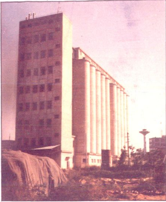
◀ 丹徒粮食中转囤仓库群，容量二万五千吨， 6 \times 30\text{m} 三五排列，二组共30只。滑模施工。质量评定优良。
