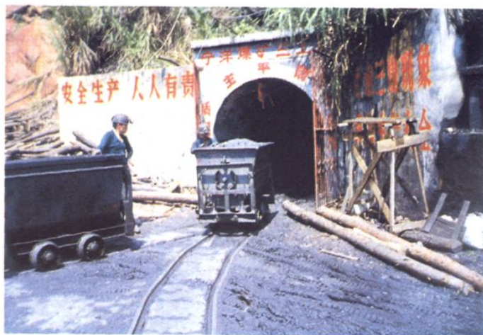
宁洋煤矿三工区主平硐在生产
