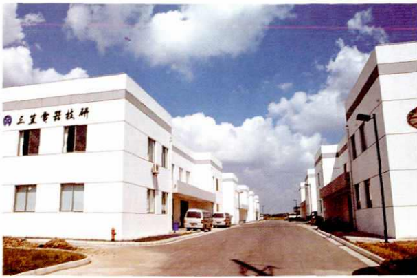
▲ 跨塘工业区三笠电器技研(苏州)有限公司 (2001年摄)
