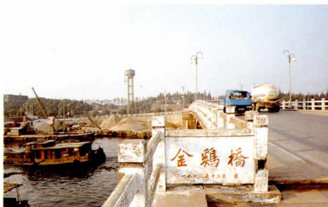
▲ 1992年新建的跨塘金鸡桥
