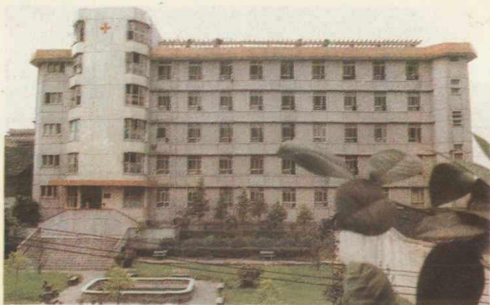
► 5. 自流井区中医院住院部
