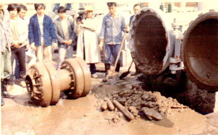
◀清管器清除的管线污物
