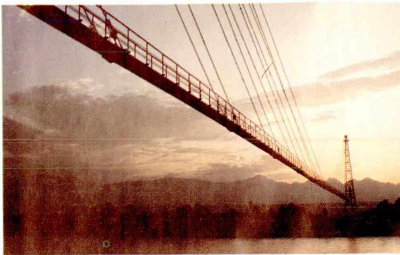
◀ 中青输气管线涪江跨越
