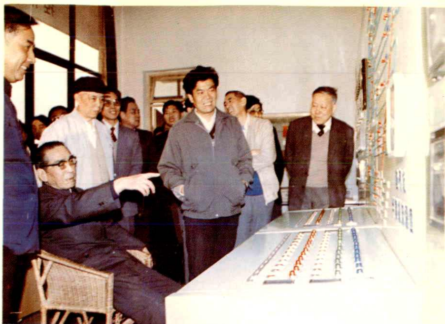
► 1991年3月24日康世恩(国务院前副总理)视察成都输气站
