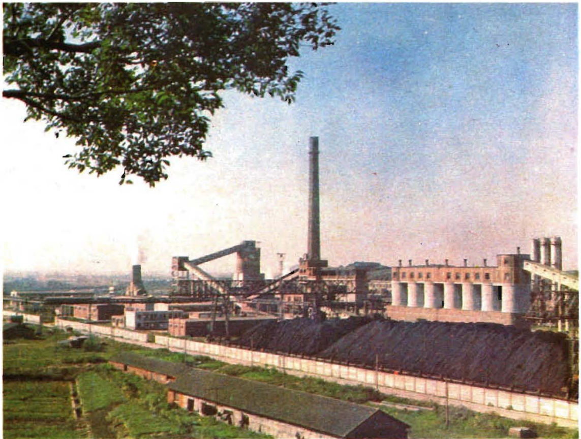
南京钢铁厂新建42孔焦炉投产 吴 斌 摄
