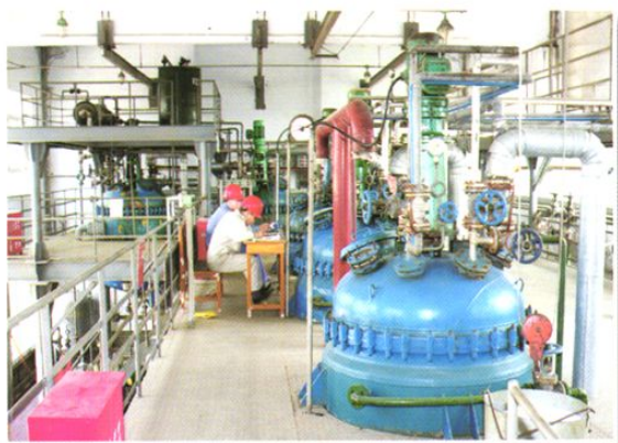
2000吨 / 年化工药剂装置
