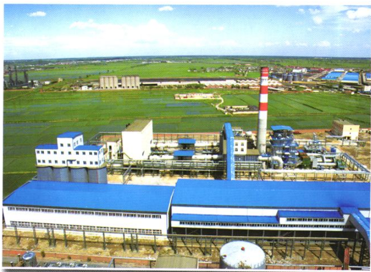
10万吨/年煅烧焦装置
