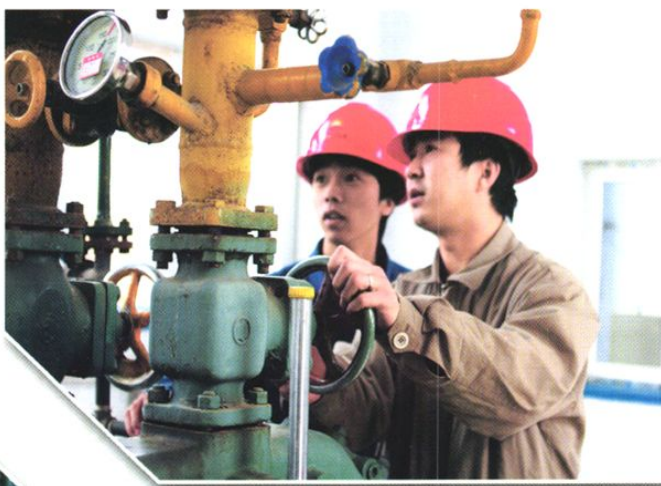
操作人员进行日常操作
