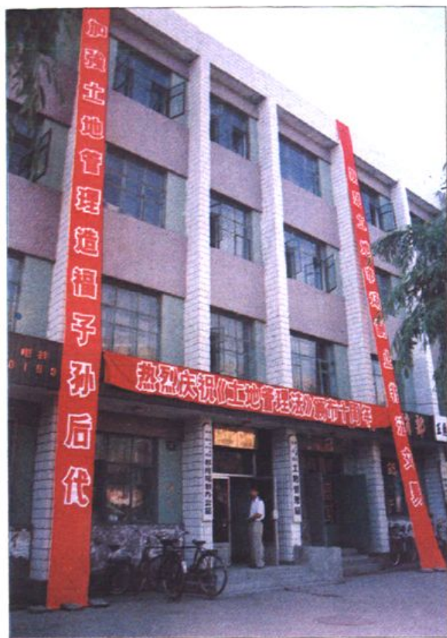
桓仁满族自治县土地管理局办公楼
