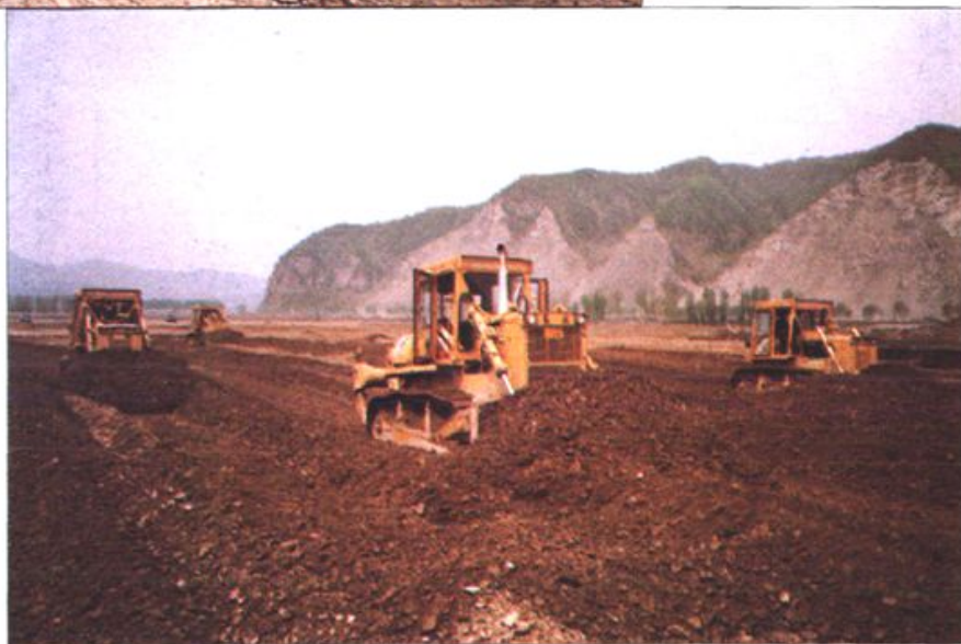
泡子沿地区新 开发 600 亩耕 地施工现场
