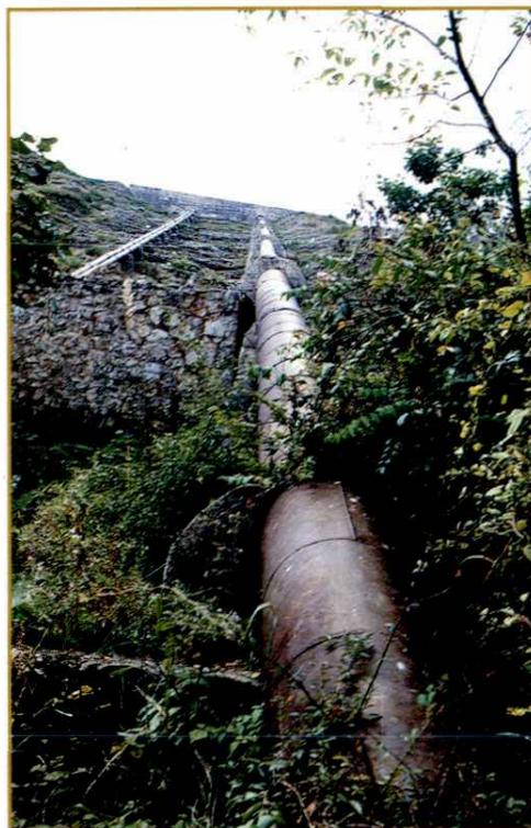
净扬程 45 米的工农兵电灌站提水管道
