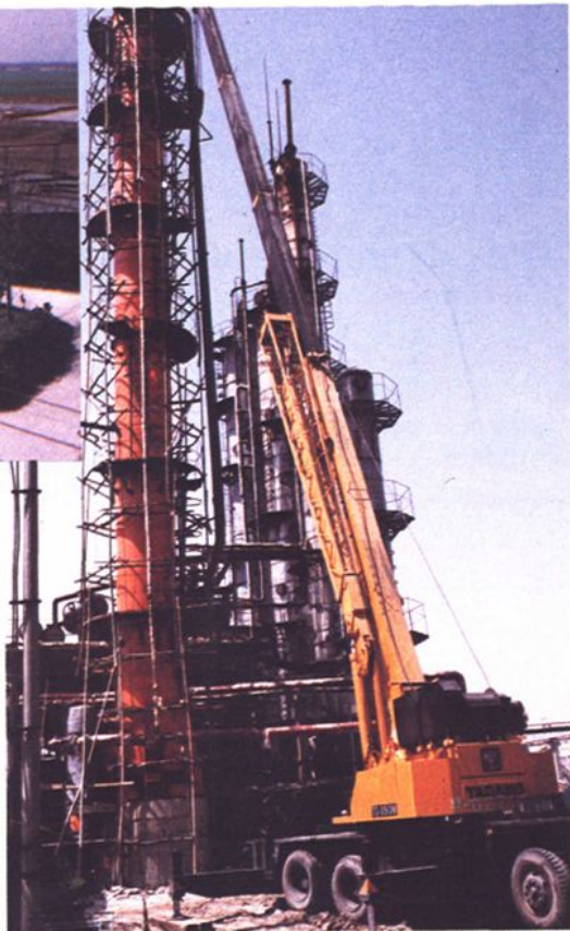
吊装甲醇装置
