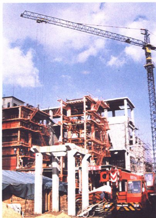
75吨锅炉按装场景
