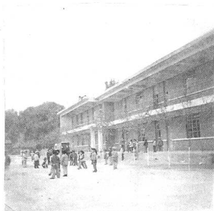
东于镇中高白村投资 38万元兴建的教学楼
