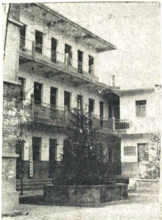
千人桥区供销办事处办公楼
