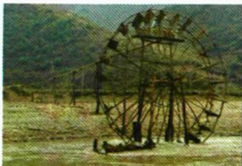
▲古老的水利工程 (赵东 摄) 设施——水车
