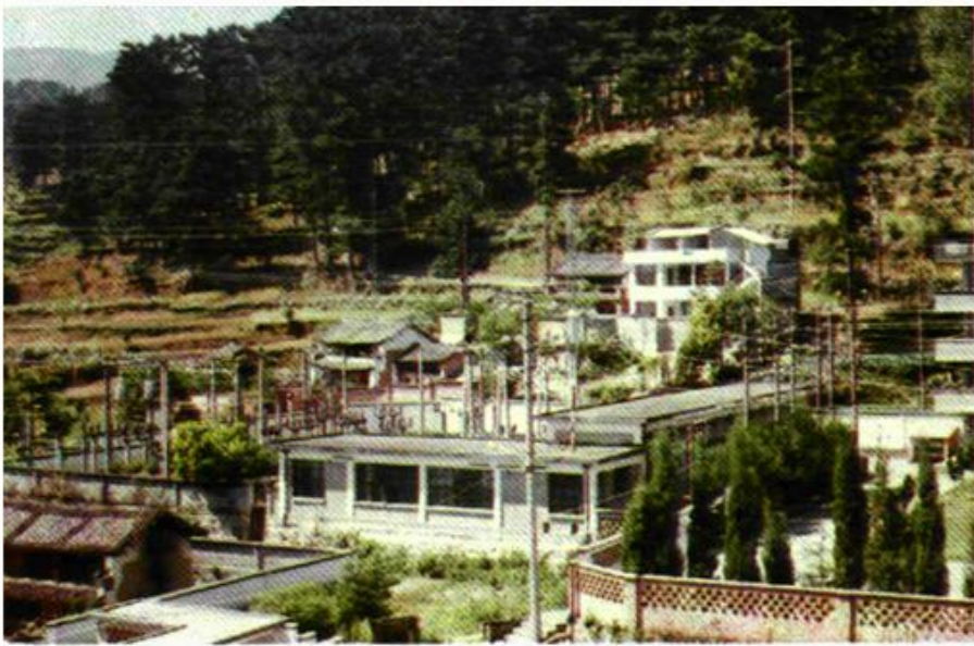
◀ 凤城中心变电站
