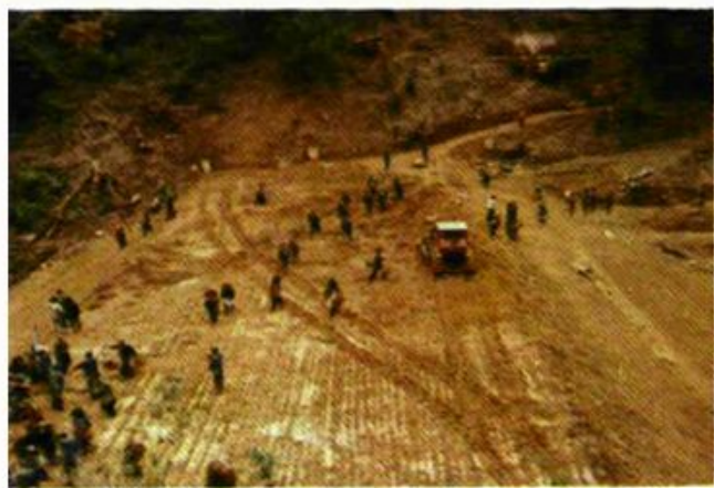
▲移山筑坝修水库
