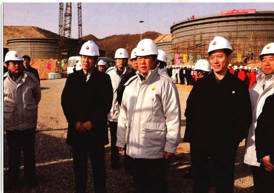
集团公司副总经理李新华到公司总承包的项目施工现场检查工作
