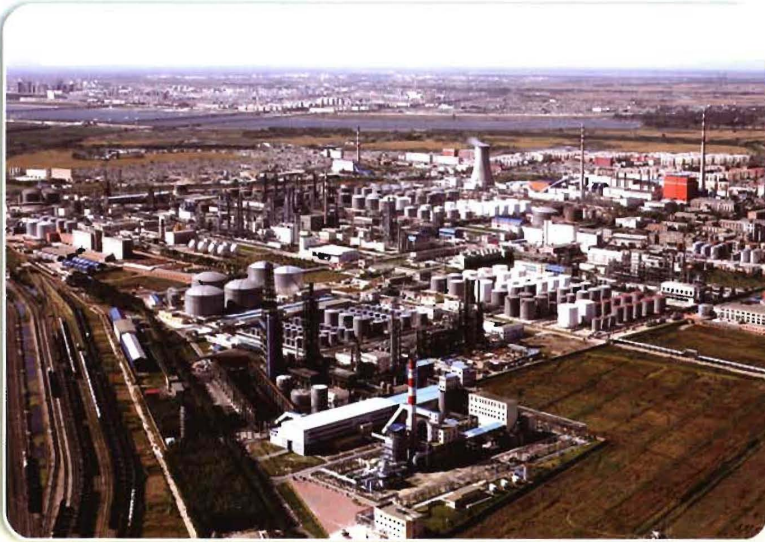
院设计的辽河油田电力集团公司发电厂
