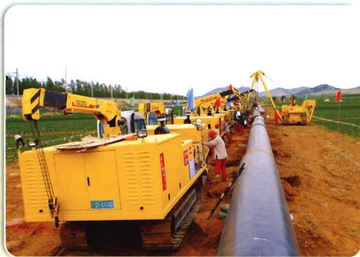
公司总承包的秦—沈管道工程施工现场
