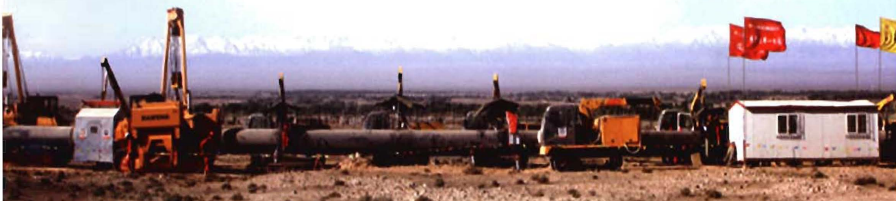
公司总承包的西气东输管道施工现场
