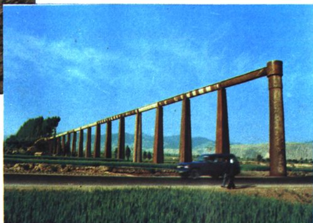
△ 三电西干渠渡槽
