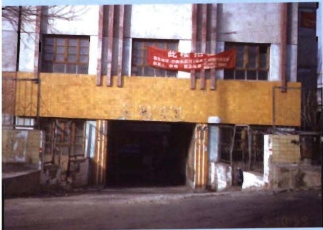
改建前的张家口水文局办公楼
