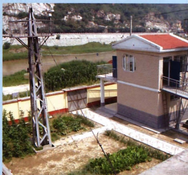
改造后的小觉水文站远程控制全自动化缆道
