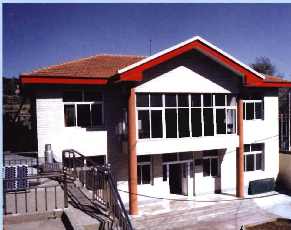
改建后的地都水文站
