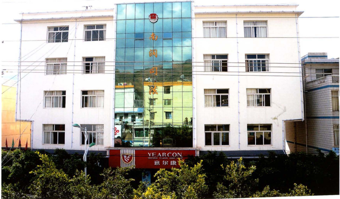
南涧县司法局综合办公楼
