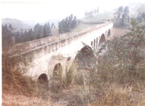
位于三溪口村的人民渠渡桥
