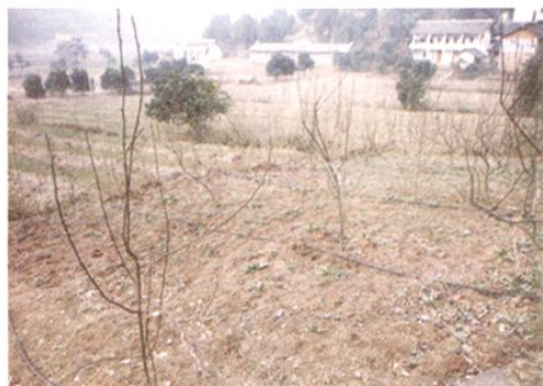
在盛水村六社梨园内修建的滴灌工程设施
