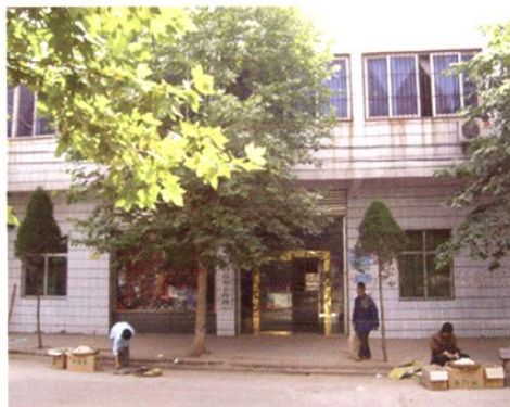
通仙场镇办公楼
