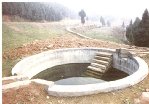
项目区内的蓄水池
