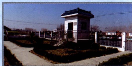
建湖黄土沟水文站，盐城水文分局首个（2009年）安装H-ADCP开展测流应用研究的水文站。
