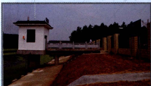
滨海滨海（通）水文站，通榆河北延送水工程水文监测系统项目，2014年建成投入使用。
