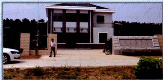
滨海水文监测中心，坐落于204国道西327省道南的通榆河边，2014年建成投入使用。
