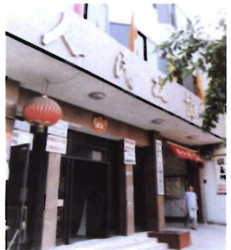
江津县政协办公大楼
