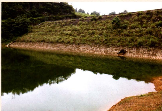
中华山水库大坝
