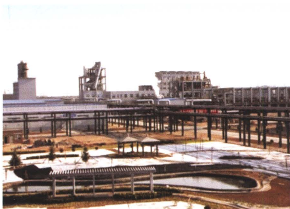
宁夏英力特公司10万吨PVC项目建成厂景
