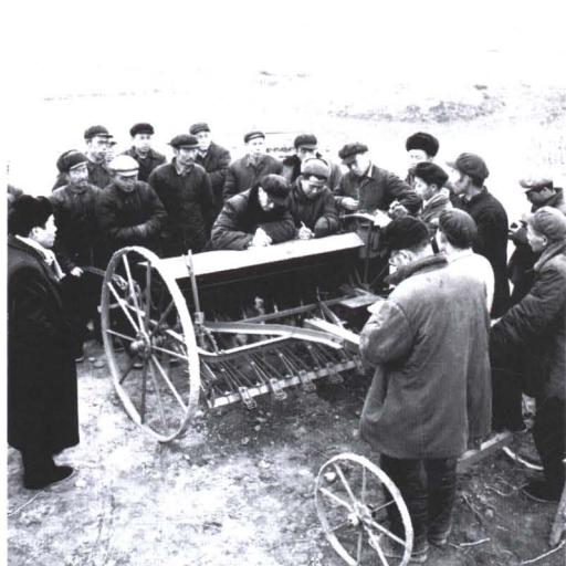
1963年3月,银川机械修配厂改制的12行条播机在平罗县调试
