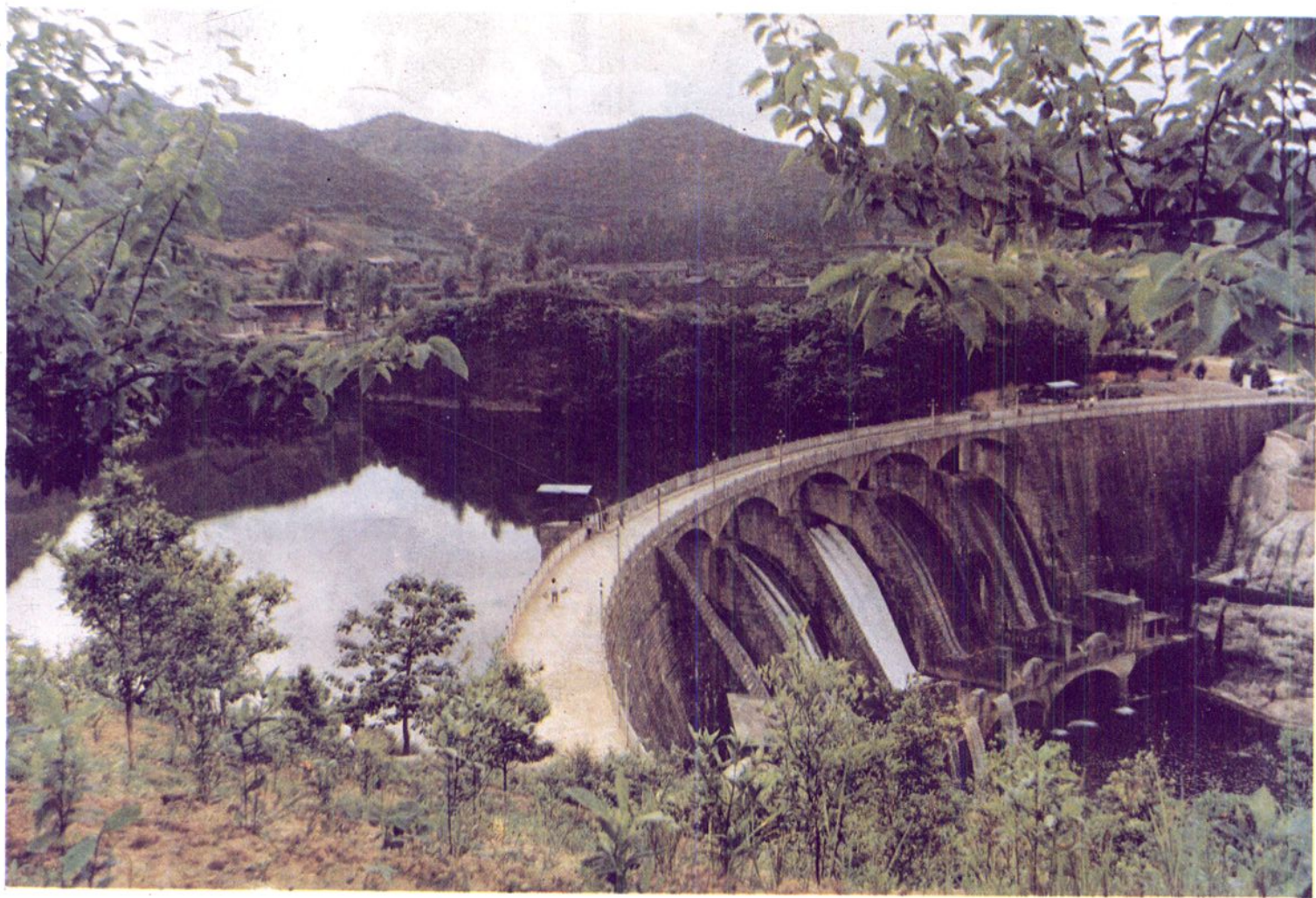
团结水库大坝枢纽
