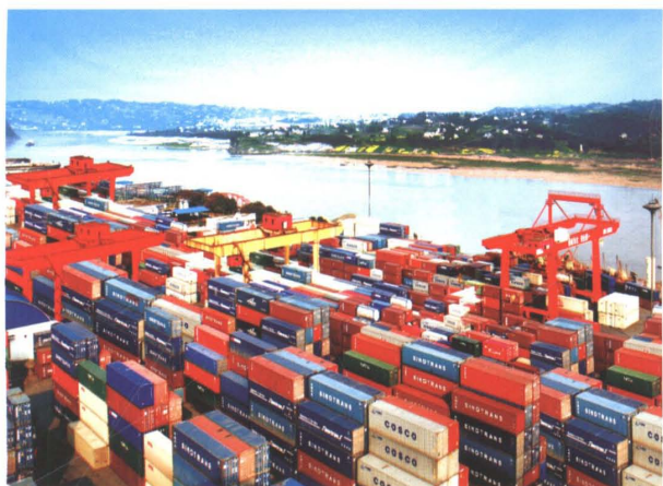
2001年4月，泸州国际集装箱码头开港
