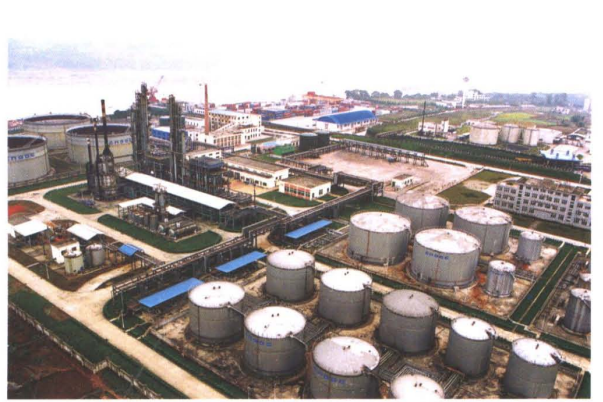
中海沥青（四川）有限公司厂区
