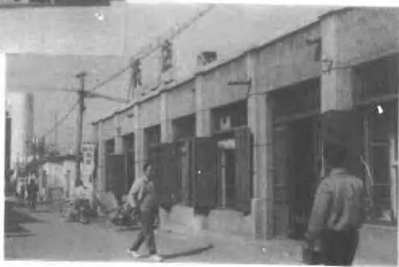
秦皇岛药材站百草堂药房 (原东鲁药房,始建于1920年)→
