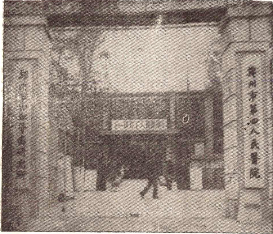
照片一、医院大门及门诊楼（1985）
