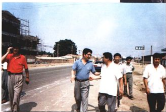
◀朱传方局长陪同市局张永平局长视察香赵庄邮电支局通信楼在建工程
