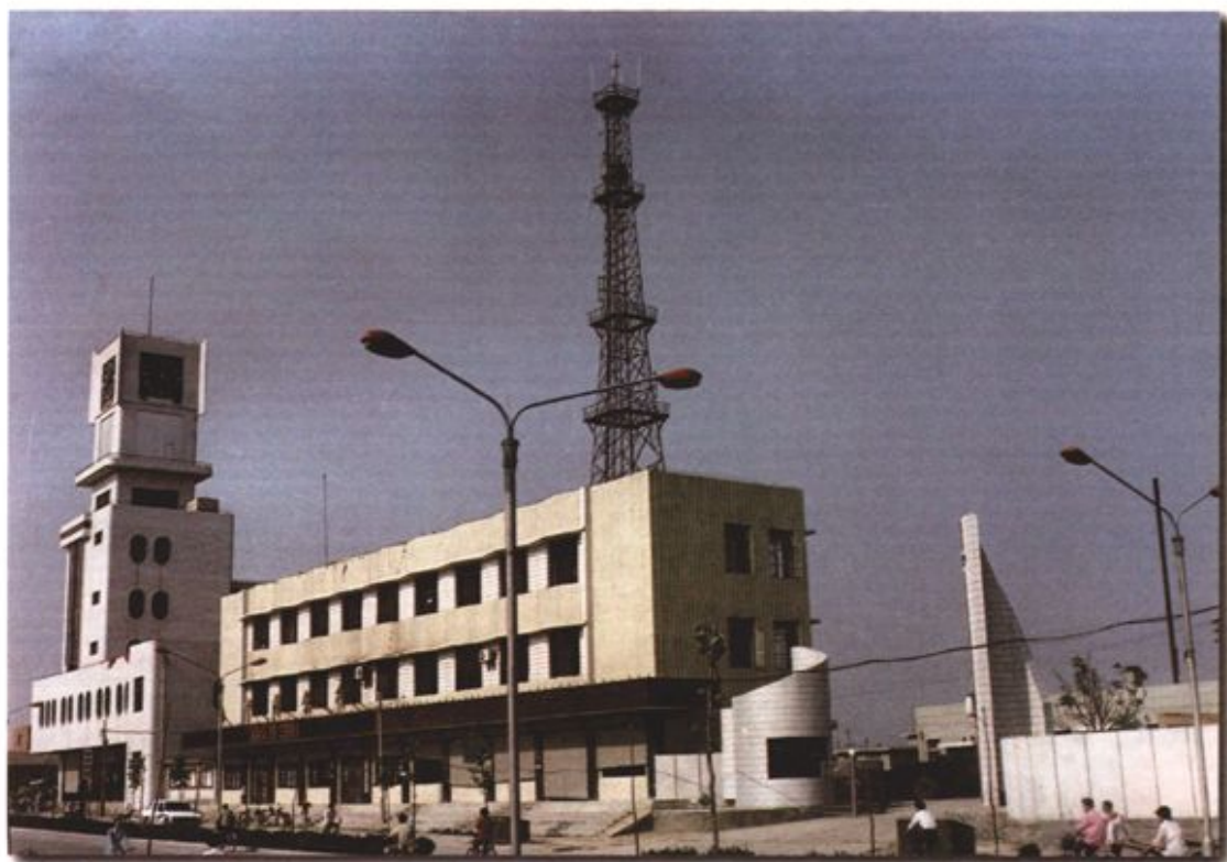
▲ 夏津县邮电局综合通信楼(1992年8月建成)
