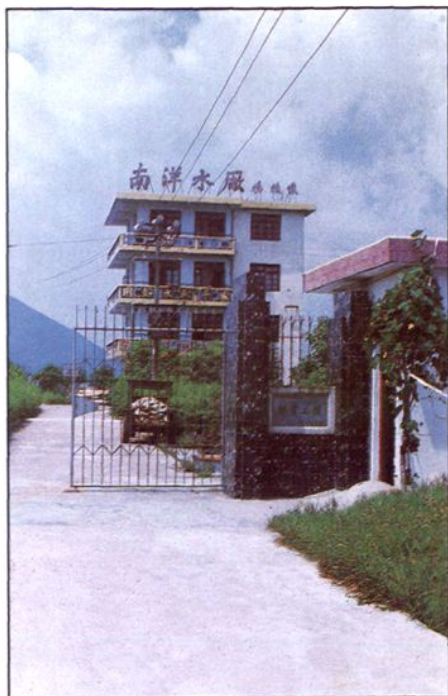
▲ 县财政帮助解决南洋片 20 万人的饮水工程经费，图为黄石镇南洋供水厂。
