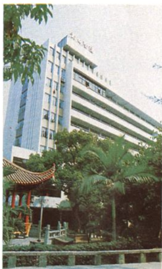
▲▶ 莆田县医院九层病房大楼及原圣路加医院大门
