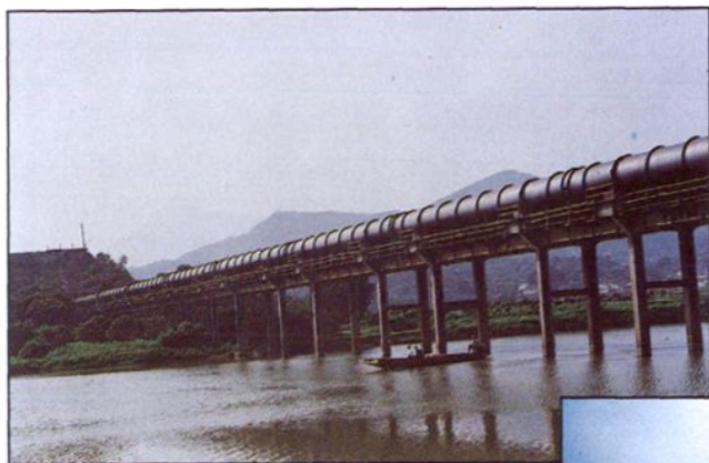
▲ 飞架木兰溪的木兰倒虹吸管。
