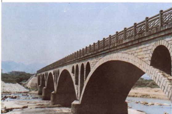
▲ 1949~1990年，县财政支持建成乡村桥梁800多座，总长度4330.4米。图为横跨木兰溪的华亭万坂桥，长188米，投资115.5万元。
