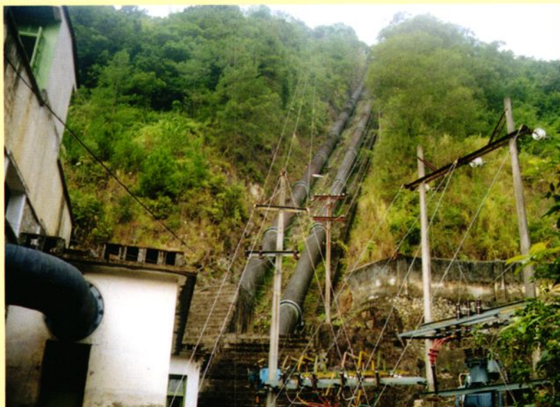
◀ 凤凰水电厂二级 电站压力钢管
