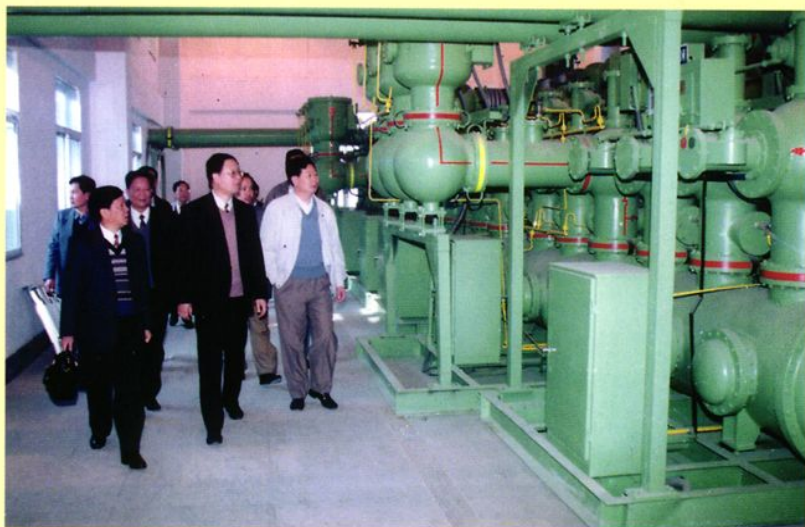
▶1996年3月2日省电力局局长吴希荣（右二），在潮州电力局局长余世渠陪同下视察110千伏春光变电站
