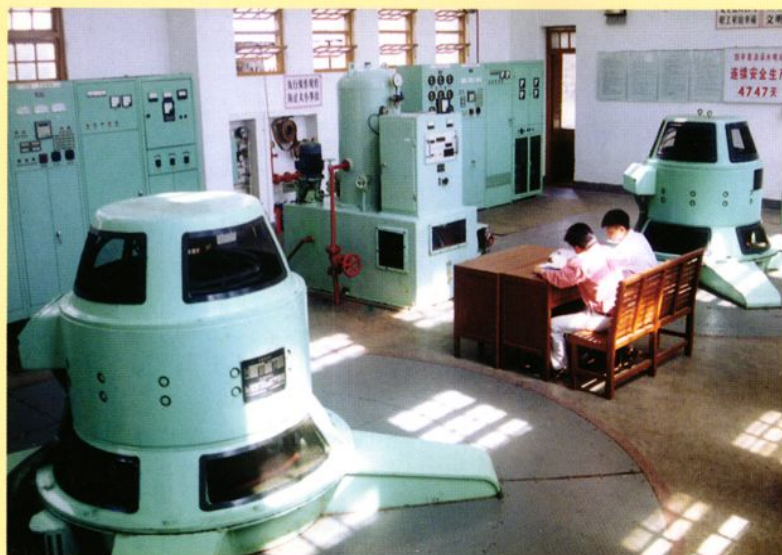
◀ 饶平县汤溪发电厂装机容量 2 \times 4000 千瓦
