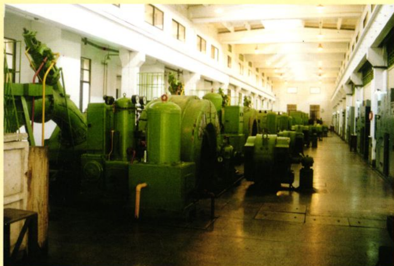
▶ 凤凰水电厂装机容量 4 \times 2160 + 4 \times 3000 千瓦
