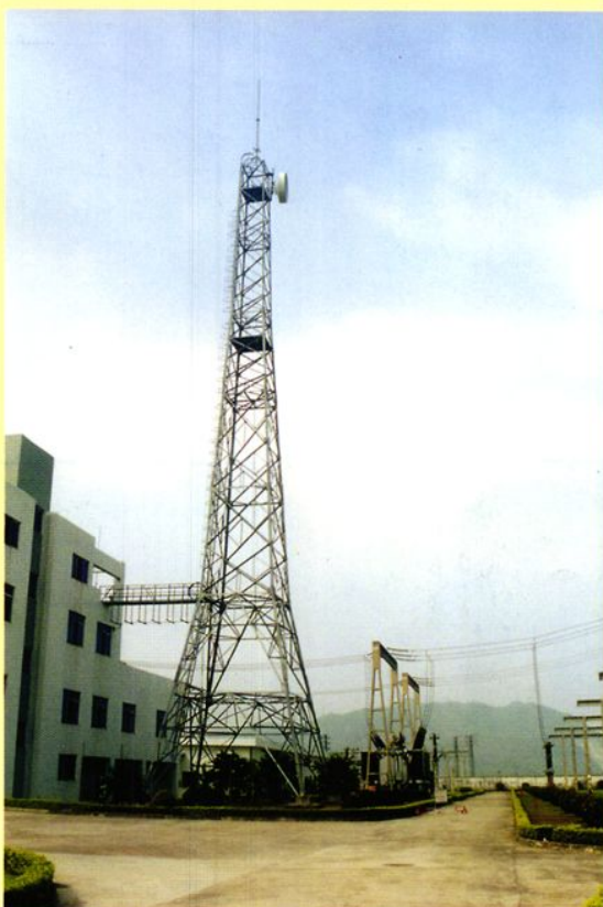
▲220 千伏金砂变电站微波通信塔
