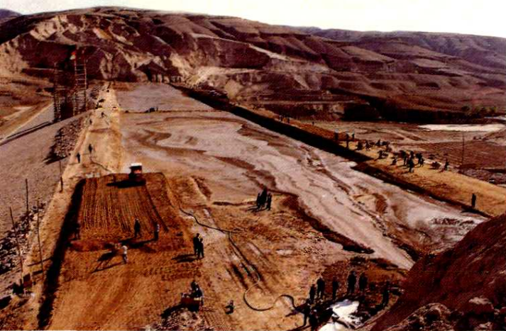
1979年临县曹家岭水库采用水力冲填法筑坝
