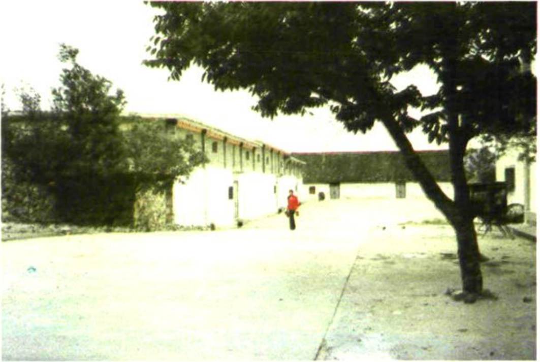
湾桥粮管所砖钢混平顶仓
