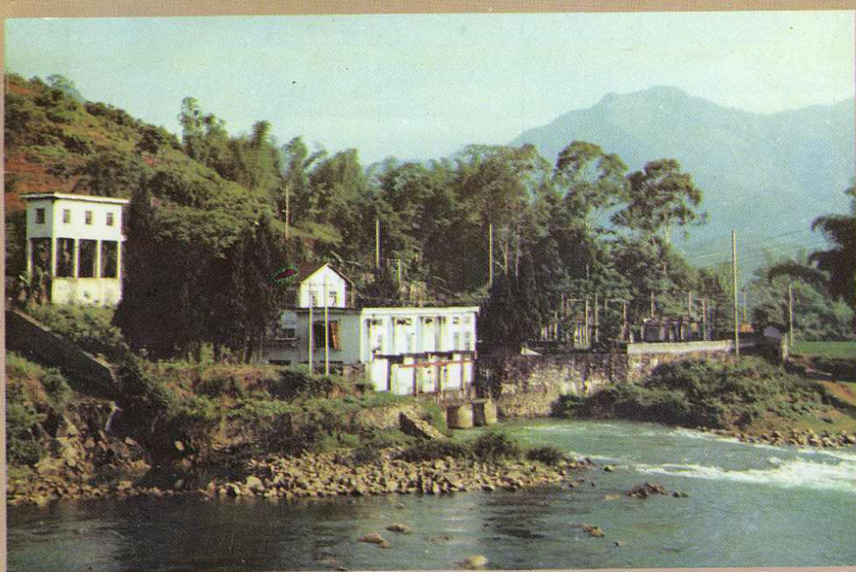
赐福水电站厂房
