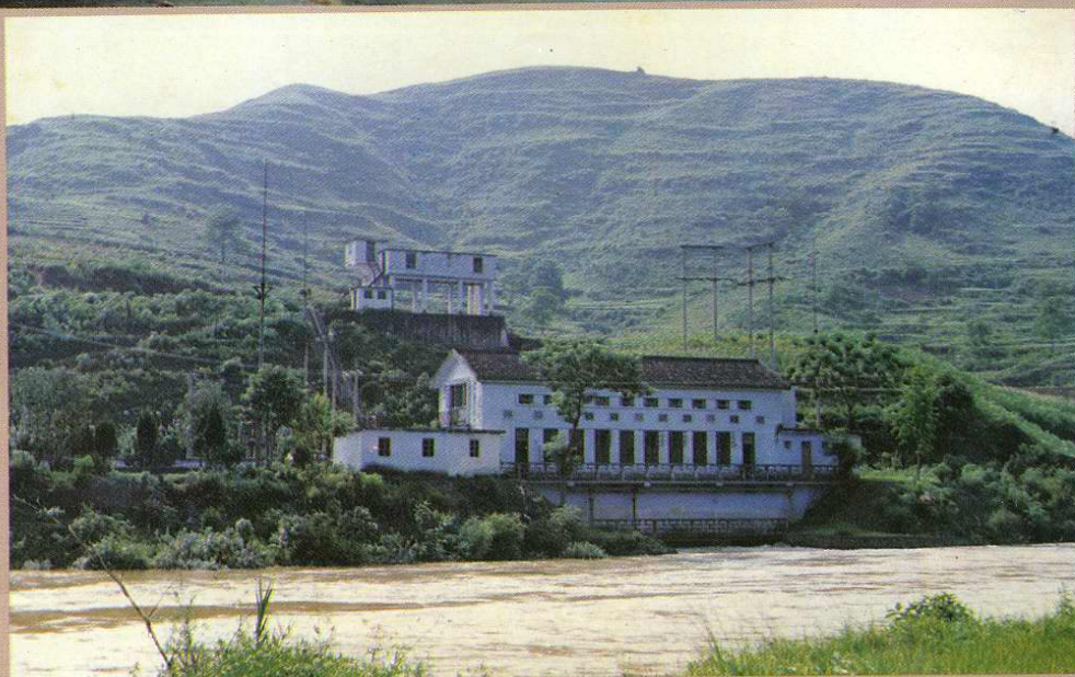
盘中滩水电站厂房
