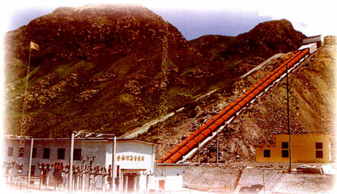
金沟河渠首电站
