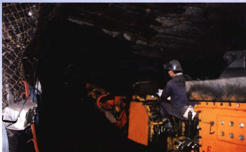
▶ 综掘锚网支护工作面
