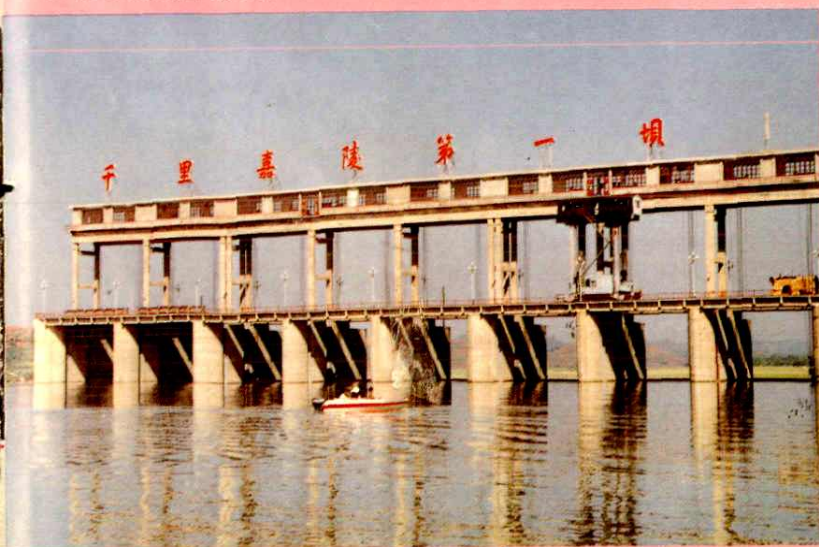
▼马回电站拦河大坝
