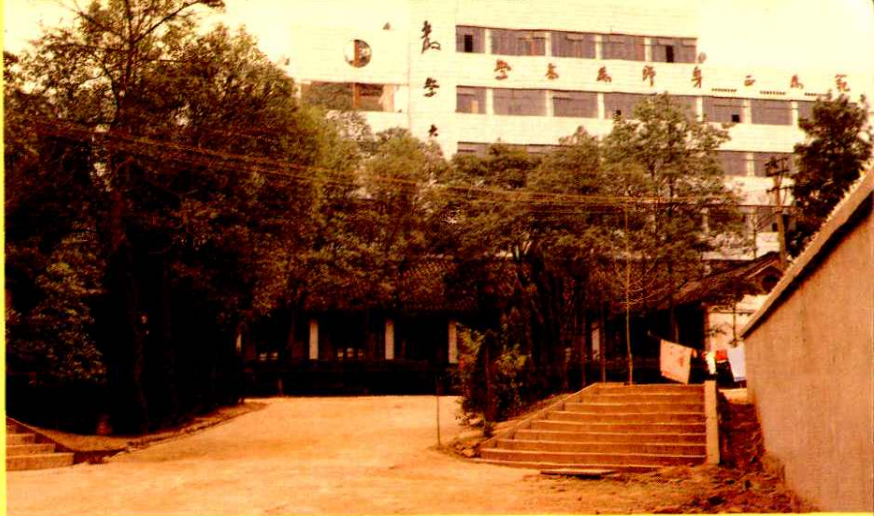
▼蓬安师范教学大楼
