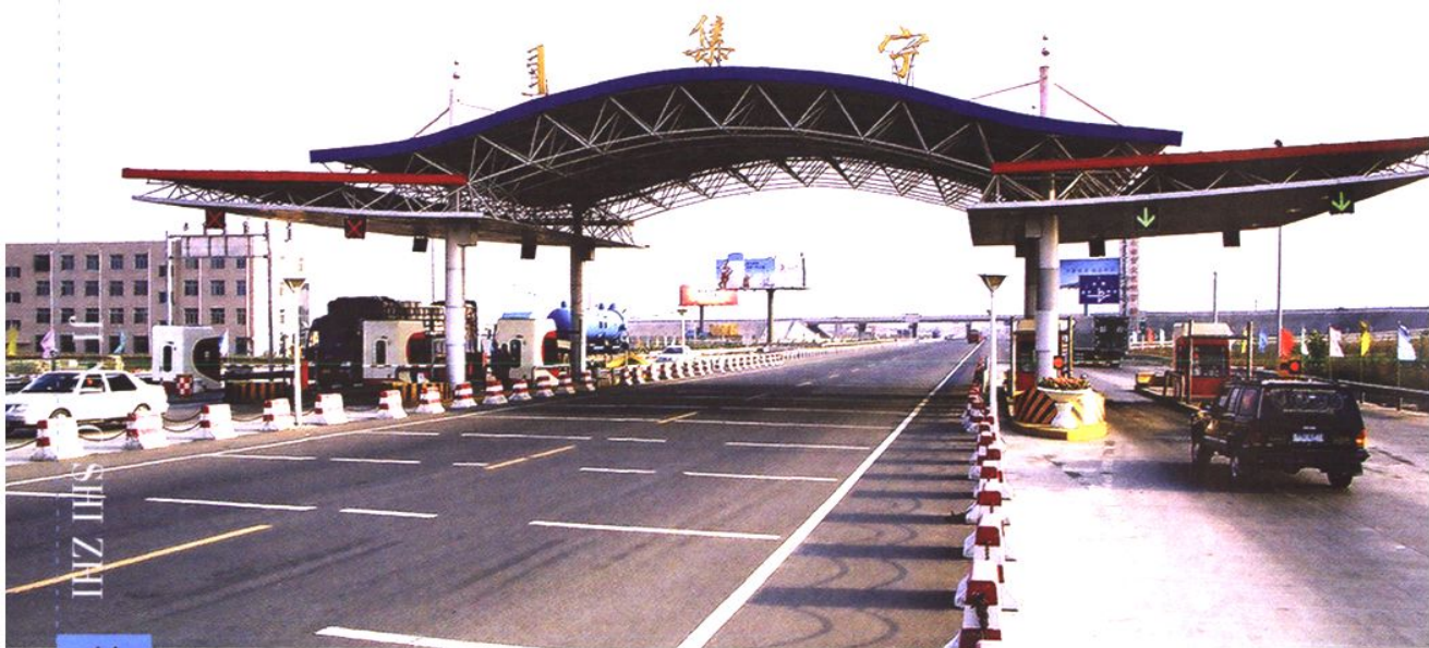
京呼(北京—呼和浩特市)高速公路集宁出入口
