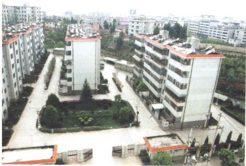
县政府住宅小区
