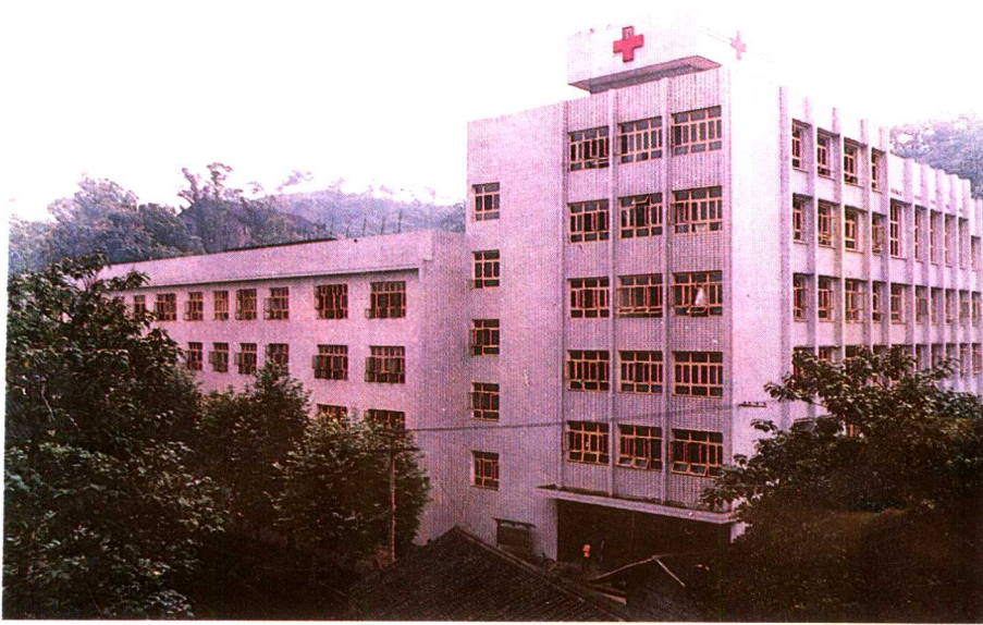
◀ 垫江县人民医院 医技大楼
