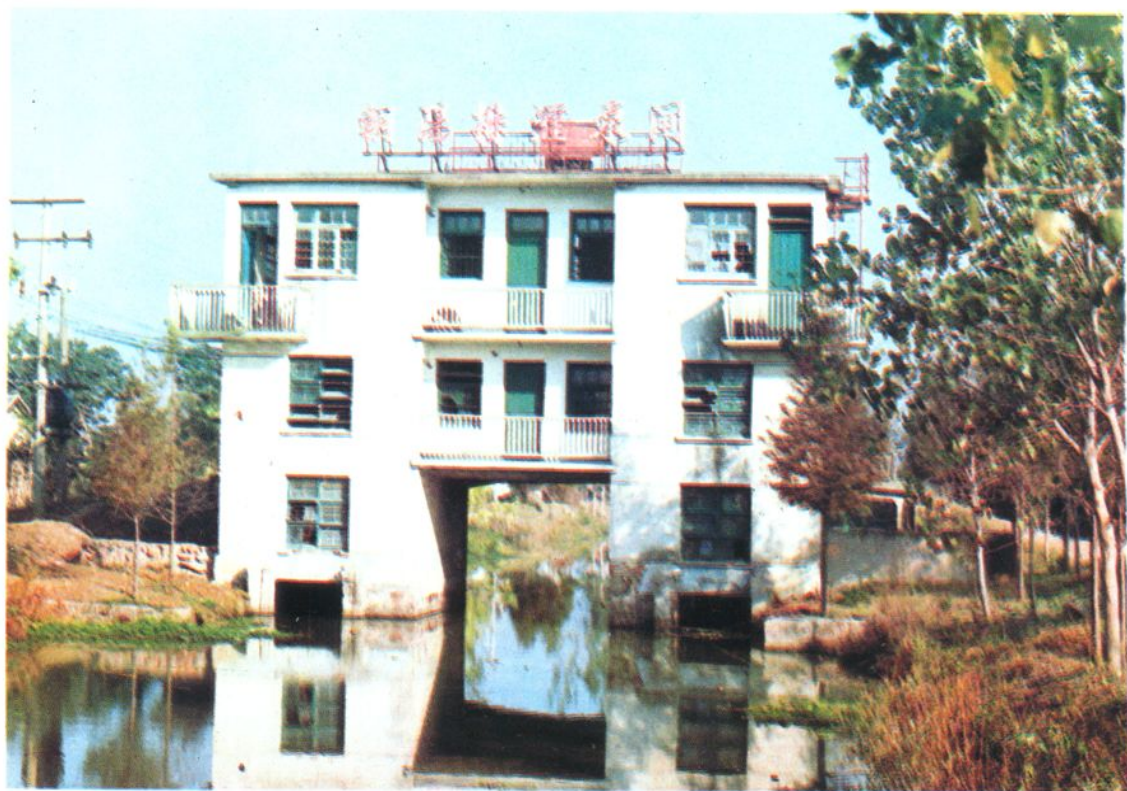
香花桥乡朝阳排灌泵闸
