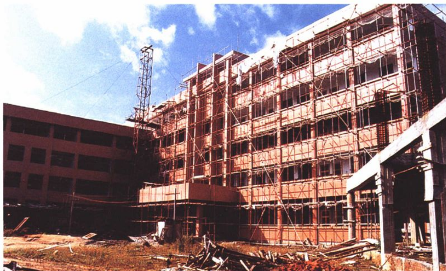
正在建设中的国债项目综合教学大楼
