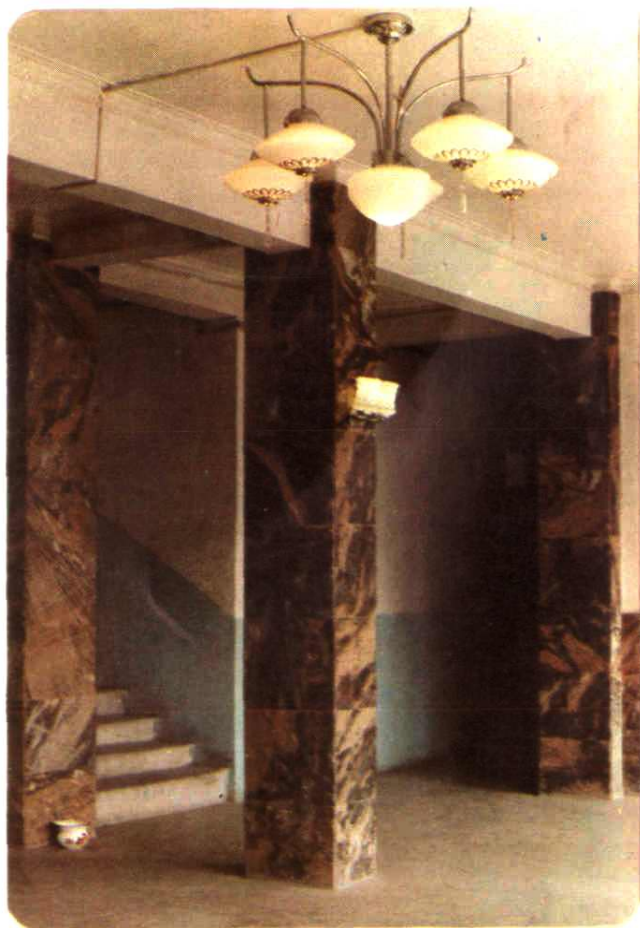
图为中共南江县委办公楼用五彩大理石板镶成的大理石柱，呈现出山水花纹；用大理石子铺成的彩色水磨石地板，光滑结实，美观大方。
