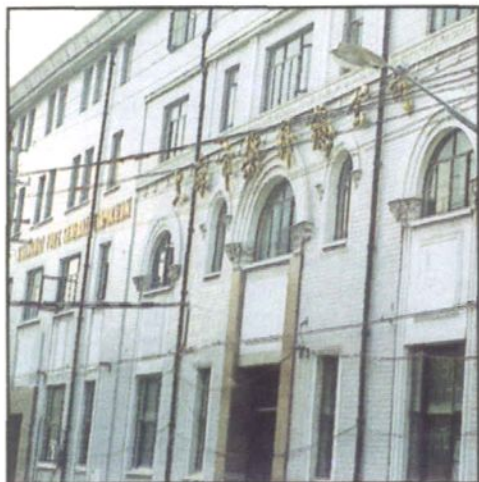
◀ 总公司办公大楼（天津路50号）
