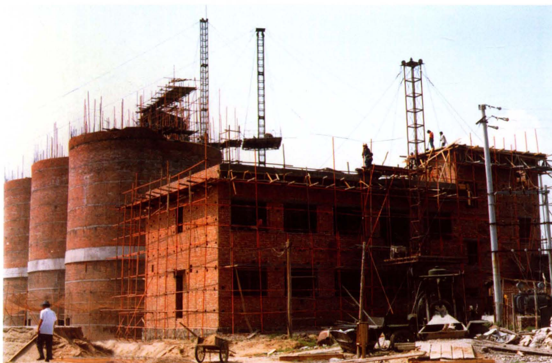
建设中的选煤厂圆筒仓
