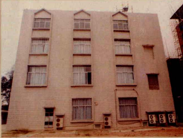
新建人和电讯大楼
