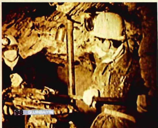
工人们在挖装炸药巷道
