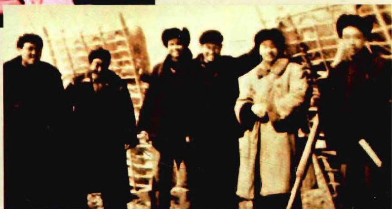
第一代勘探队员在黄河岸边勘探水源
