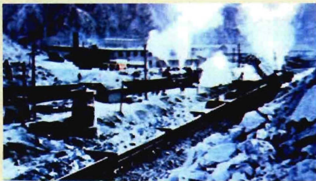
开发建设初期的建设工地
